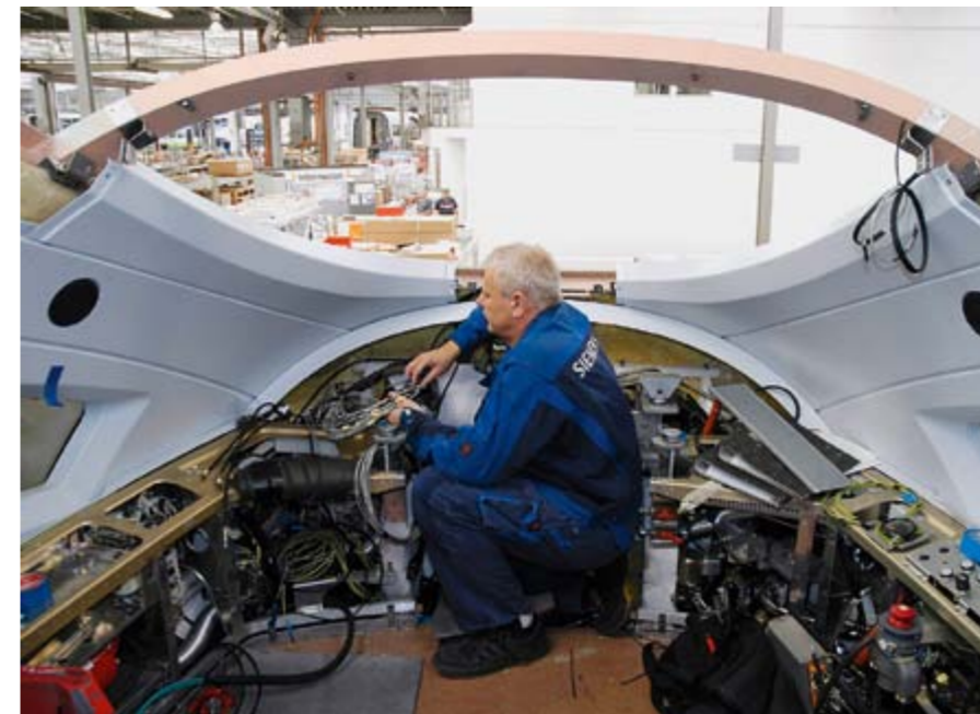
Bild 5: Verkabelung des Führerstands
